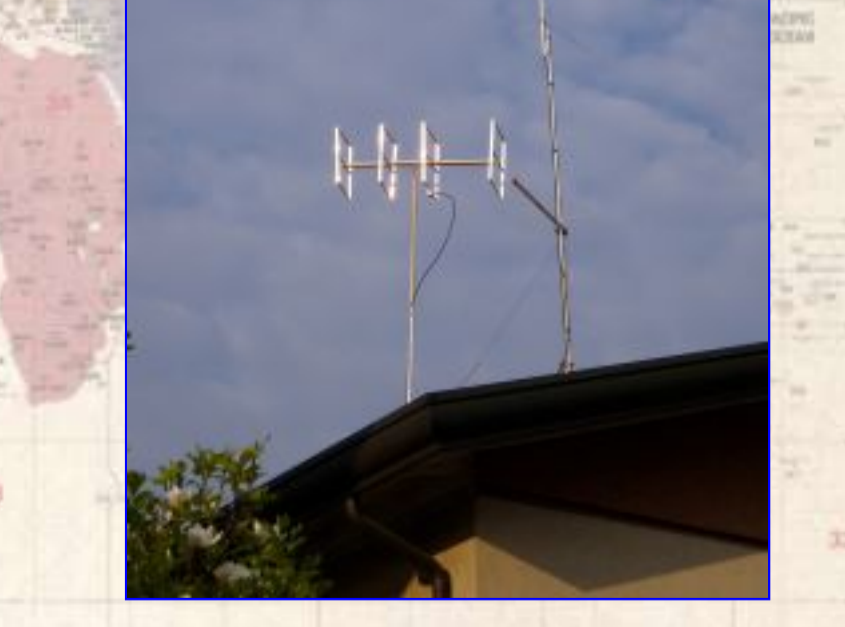
Foto 6 (Posizionamento dell'antenna sul tetto)
