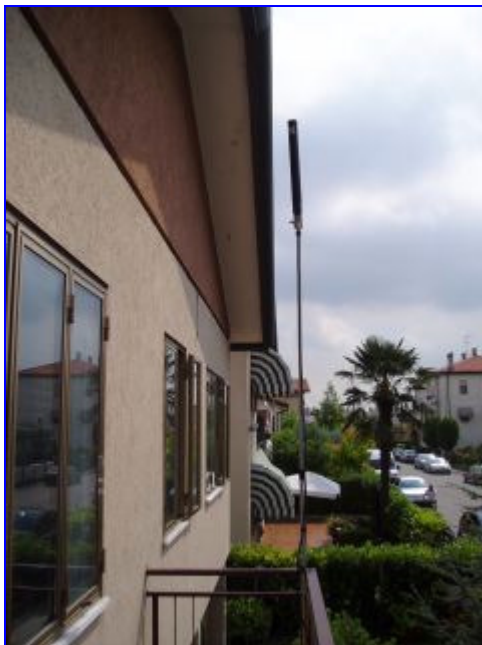
Foto 7 (Posizionamento sulla terrazza )
